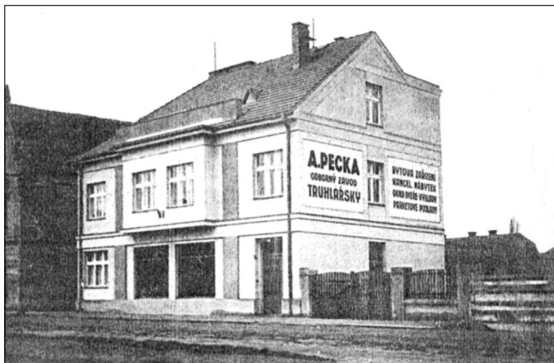
Dům rodiny Pecků s kanceláří firmy a prodejnou nábytku v přízemí kolem roku 1945
